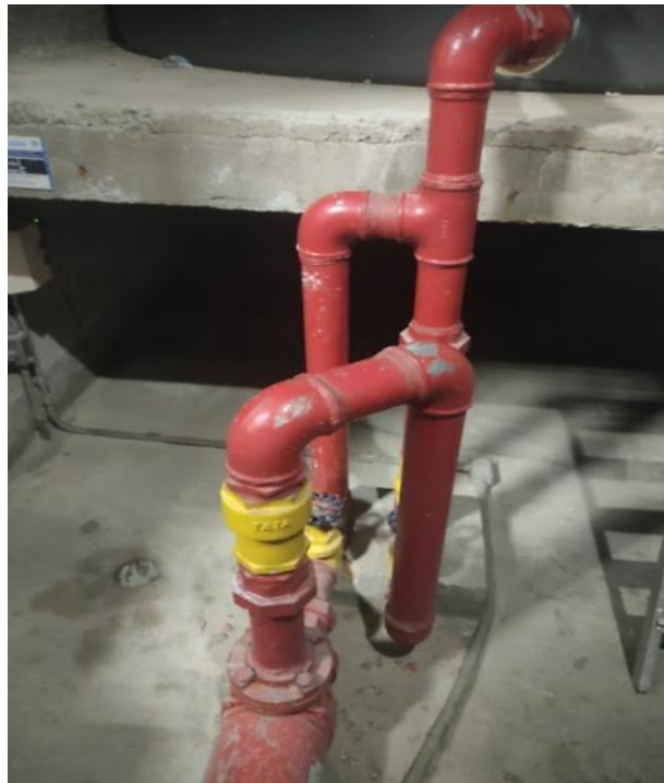
Figura 8 - Bomba de Incêndio
